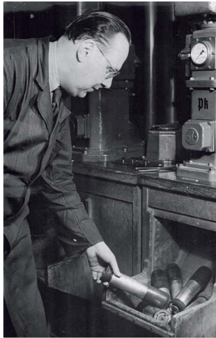
Das Foto von 1951 zeigt einen Mitarbeiter in der Zentrale der Berliner Rohrpost , dem Haupttelegraphenamt in der Oranienburger Straße in Mitte, bei der Weiterleitung der Büchsen an ihre Zielpostämter.
