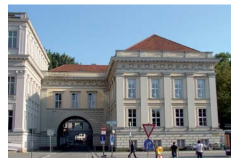
Prinzessinnenpalais Ein Durchgang zwischen den Obergeschossen (Schwibbogen) verbindet seit 1811 das Prinzessinnenpalais mit dem Kronprinzenpalais.
